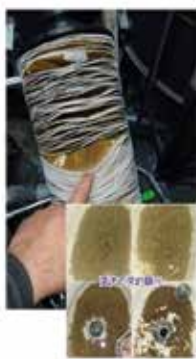
▲約使用 2-3 個月後，超濾膜表面攔截水中雜質及沙土
